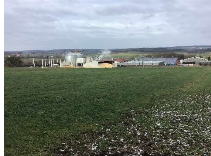
Abbildung 20: Blick von Süden auf die Bestandsgebäude (Quelle: Eigene Aufnahme 31.01.23).
